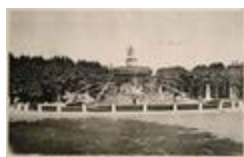
Fontaine monumentale, ou Fontaine de la Rotonde, ou Fontaine des Trois Grâces (1860)
