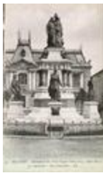
Monument des trois sièges de Belfort, ou Monument à Denfert-Rochereau (1912)
