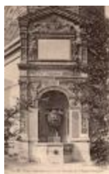
Fontaine de l'ancien réservoir (1835)
