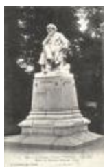
Monument à Pierre Leroux (1903)
