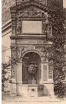
Fontaine de l'ancien réservoir (1835)
