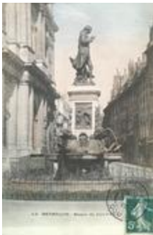
Monument au marquis Jouffroy d'Abbans (1884)
