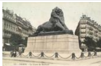
Le Lion de Belfort, et Hommage à Denfert-Rochereau (1880)
