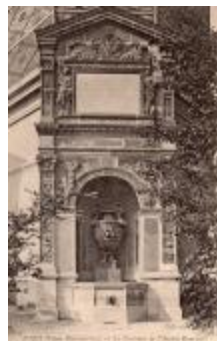
Fontaine de l'ancien réservoir (1835)
